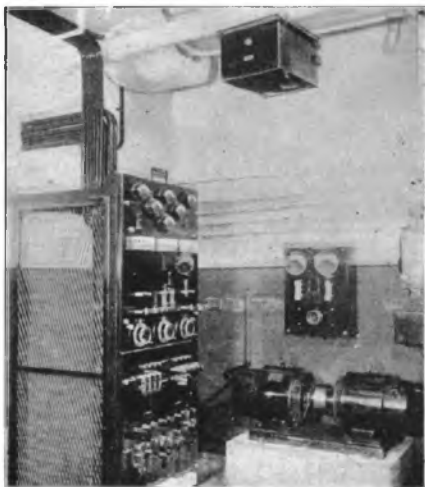
De hoogspanning-installatie van den zender en versterker
